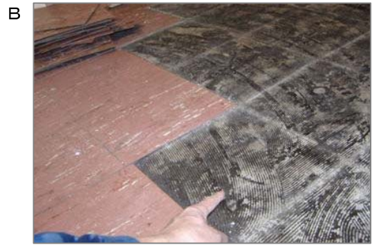
床の石綿含有ビニル床タイルは重歩行度や温湿度、経年などで劣化(剥れ、浮き、磨耗など)します。この黒い接着剤にも石綿は混入しています。張替えはこの接着剤をキレイにサンダー掛しますが、その際に石綿にばく露する可能性があります。
