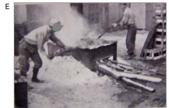
①昭和30年代のアスファルト工事(昭和60年頃まで)。アスファルト(石炭副産物・コールタール)の塊をフネ(鉄板の桶)に入れ、下から溶けるまで熱します。アスファルトに石綿を混ぜた時期があったようです。①から③の順で作業が行われます。
