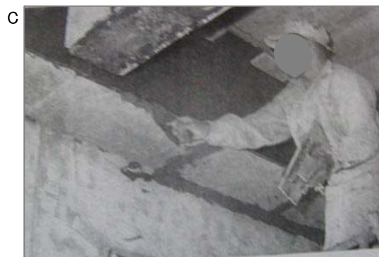
C 吹きつけとは別の工法で茶石綿で出来た石綿耐火被覆板の張り工事。クギ、カスガイおよび石綿含有耐熱接着剤で留めます。昭和45年前後の工法で、吹き付けに比べればばく露量は少ないですが、現場で切断加工する際には粉じんが発生しました。
