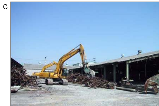
C スレートの屋根・壁のある倉庫の解体作業。粉じんの飛散防止のため、散水しながら作業をする必要があります。
