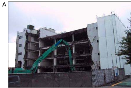
A 側面からのビル解体作業。吹きつけ材、内外装材、煙突などの建材や空調のダクトパッキング、配管エルボ等は解体前に石綿含有無の調査が義務づけられ、重機作業の前に石綿製品を除去してから解体しますが、以前はそのまま解体されていました。
