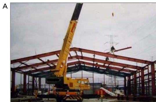
A 鉄骨で建物の骨格を作ります(鉄骨工事・とび職)。建物の仕様・要求によりこの柱や梁に後から耐火被覆(石綿の吹きつけ)を施工します。
