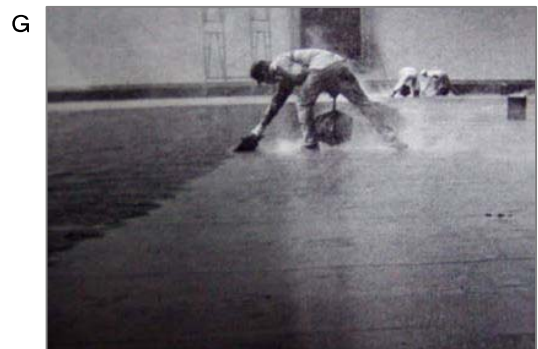
③最後のタールを上塗りしているところ。打ち粉として微小な石綿をふっていたかもしれませんが確認できていません。このあとの時代は、石綿とは関連のないシート防水が主流になりました。
