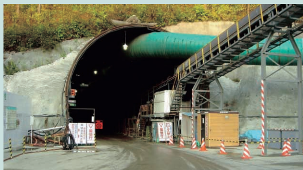
掘削岩搬出ベルトコンベヤ（坑口部）
