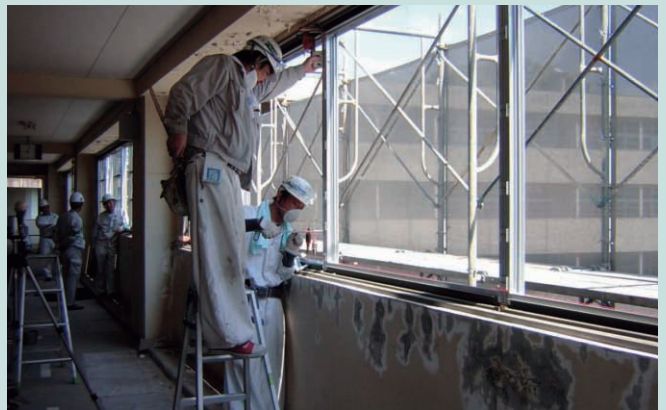
小学校の窓改修工事（サッシの位置決め作業）
