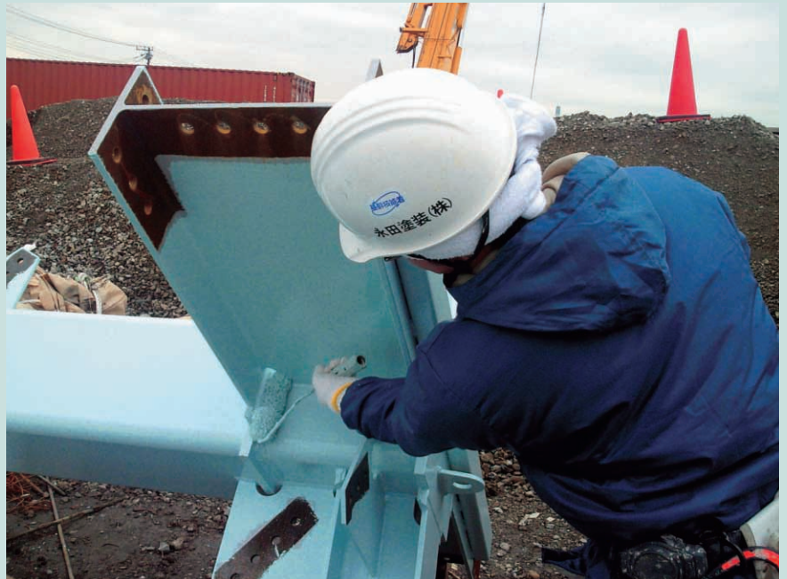
新築工事の鉄骨塗装
