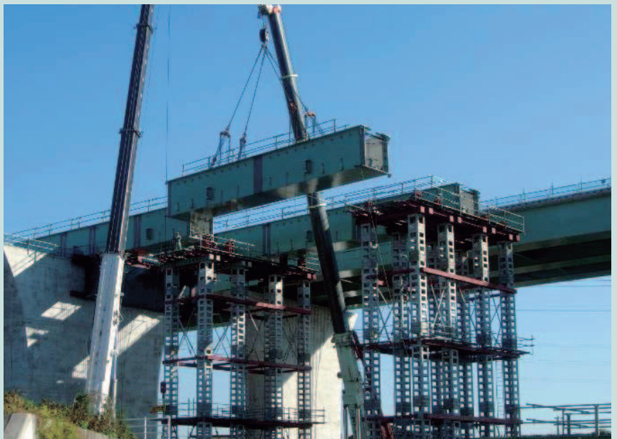
トラッククレーンベント工法の架設状況
