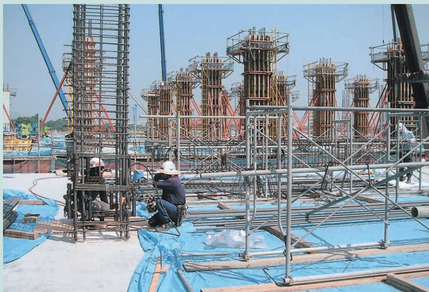
先組み梁筋のガス圧接
