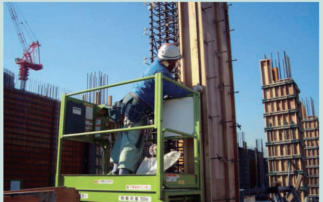
柱型枠の組立て
