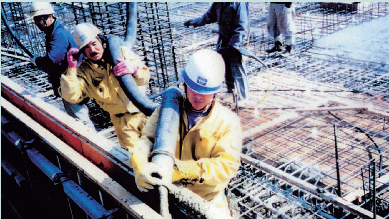
コンクリート圧送工事における筒先作業（手摺り部分）
