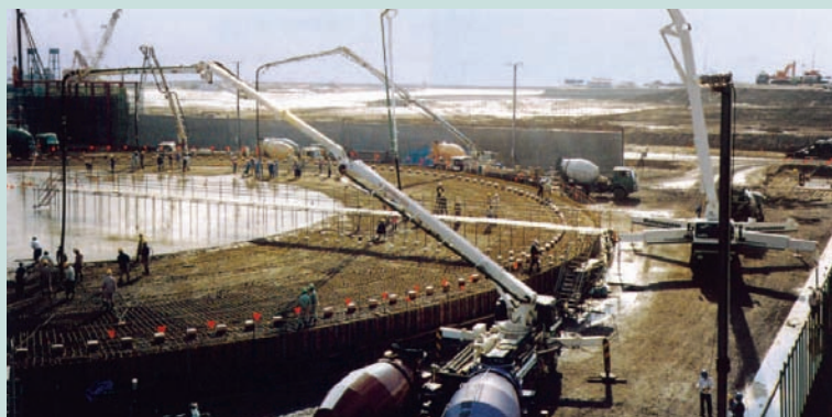
52m超ロングブーム車による圧送工事（ガスタンク）
