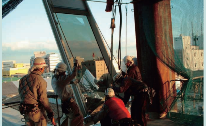
CWユニットの吊出し作業
