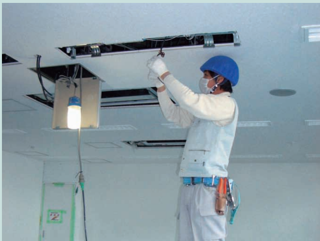
照明器具取付け作業
