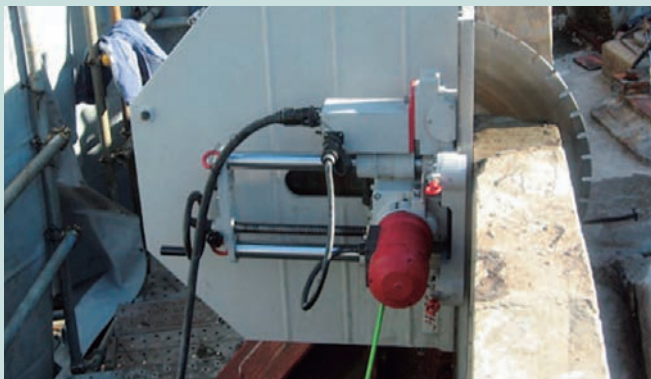
ウォールソー工法（コンクリート切断）
