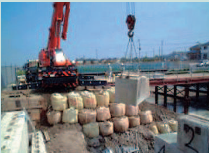
7.ブロック吊出し
