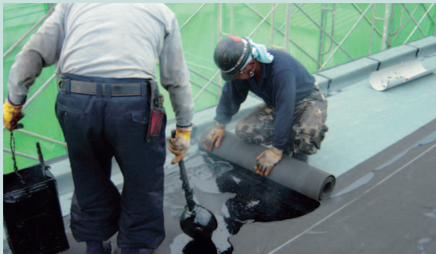
アスファルト系防水熱工法による施工
