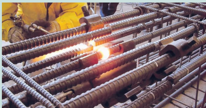
先組み梁筋のガス圧接
