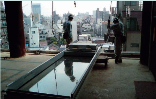
CWユニットの吊出し準備
