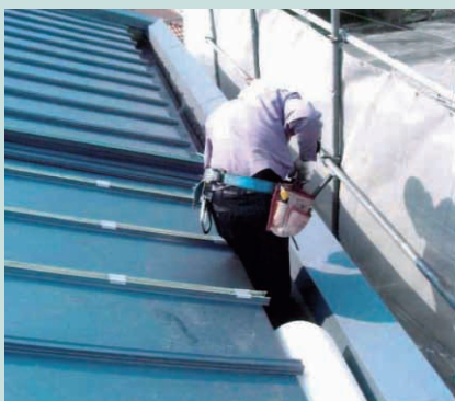
屋根軒先部分仕舞作業
