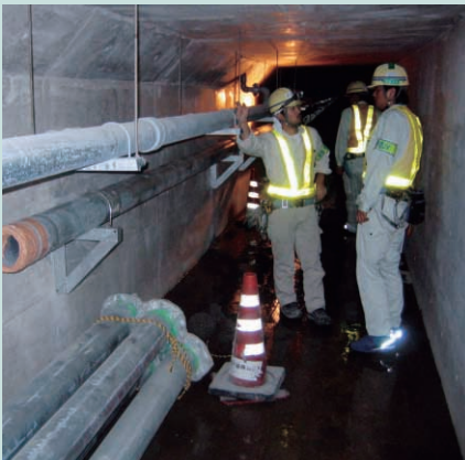
トレンチ内の主配管施工
