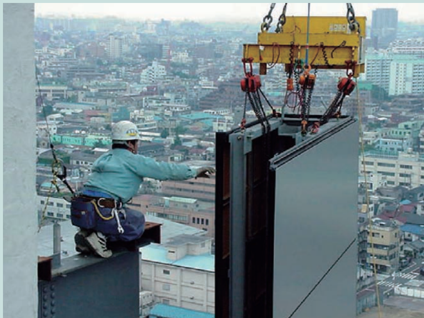
外壁パネルの吊込み作業
