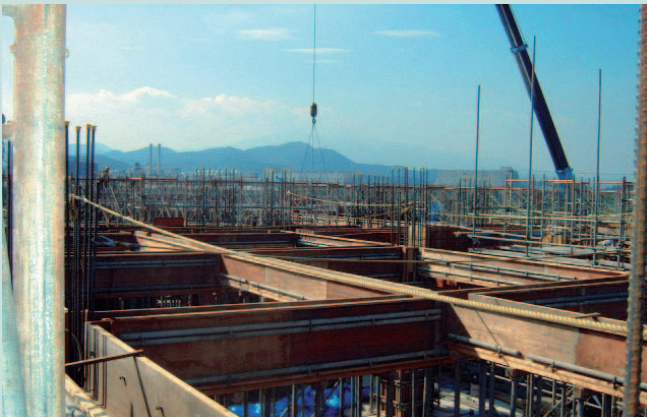
壁・梁型枠の組立て
