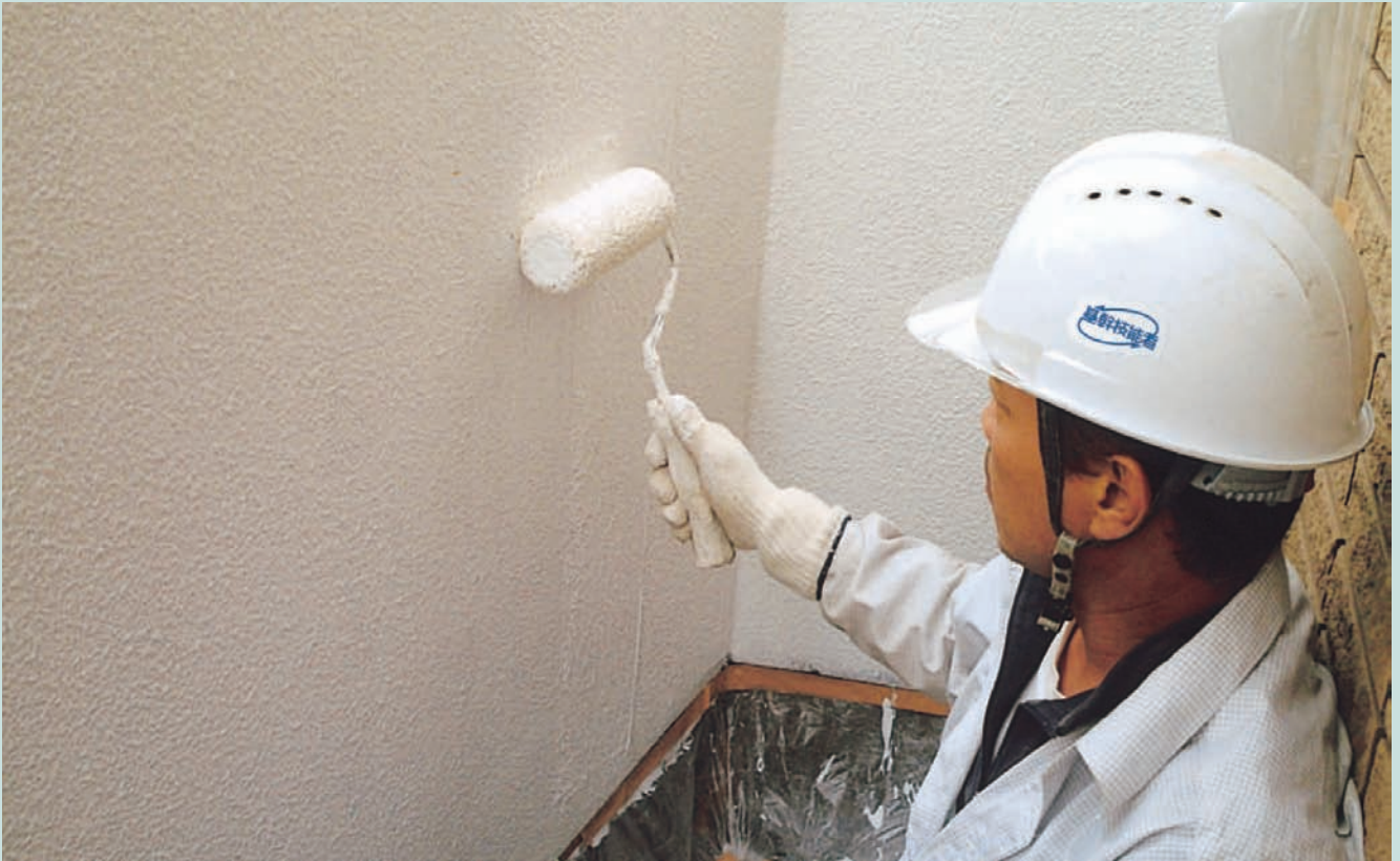
吹付け仕上げ施工
