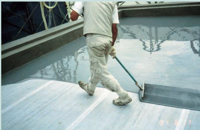
ウレタンゴム系塗膜防水の平場塗り作業
