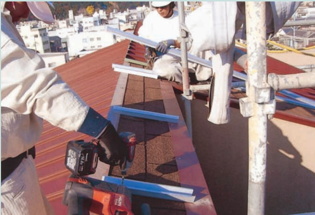
現場作業風景
