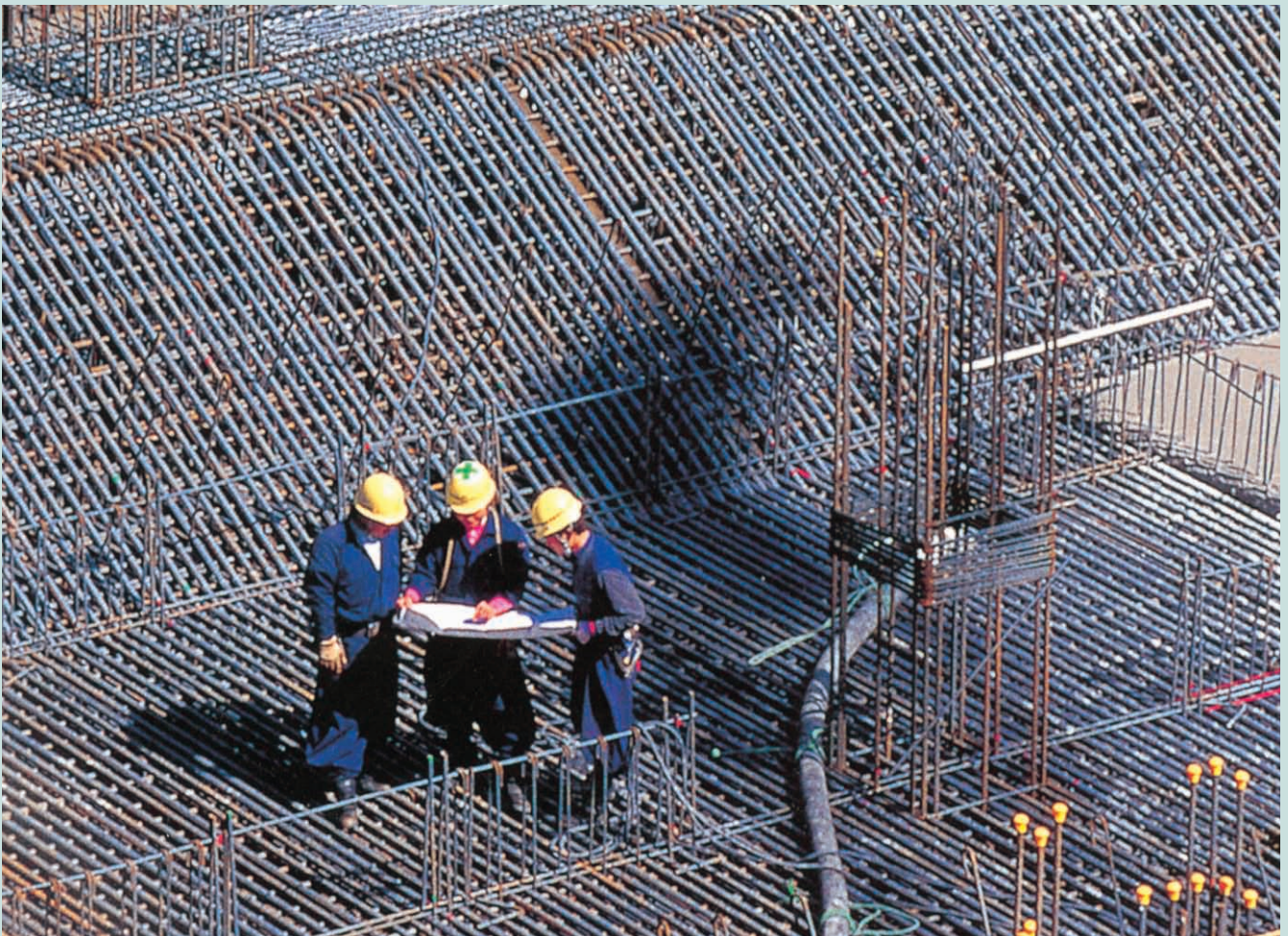
先組みでの配筋作業
