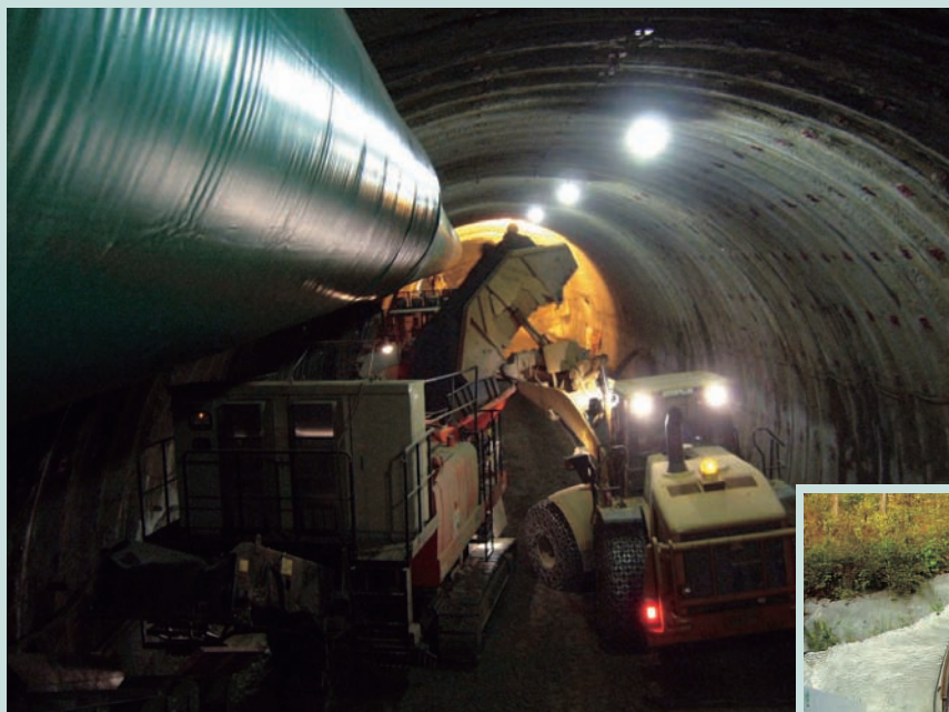
掘削岩ベルトコンベヤ搬送前クラッシャー投入作業
