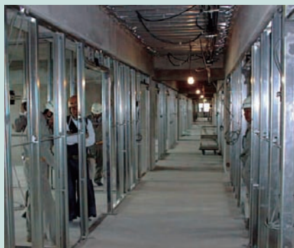
壁鋼製下地材工事施工
