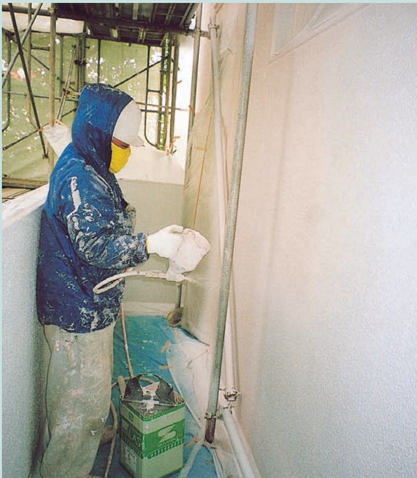
ガン器を使用した吹付け仕上げ施工
