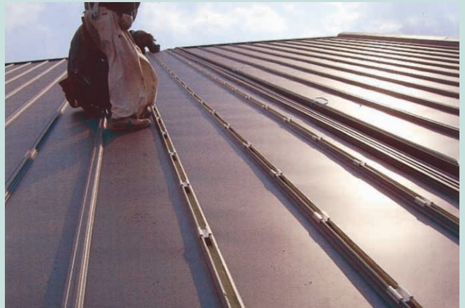
瓦棒ぶき施工
