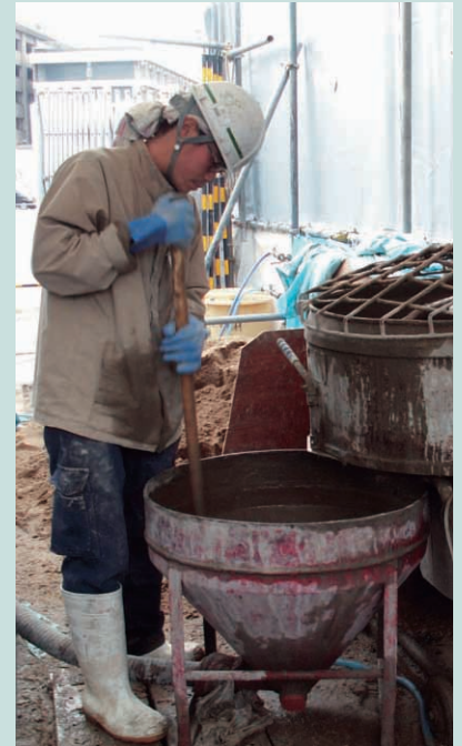
モルタルポンプによる圧送工法
