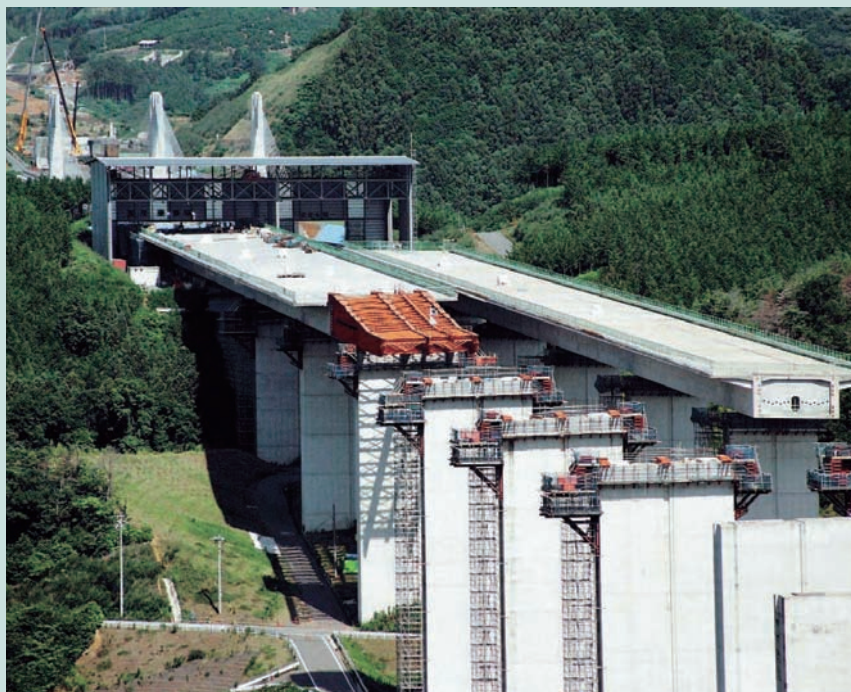
現場製作による主桁の押し出し架設の連続箱桁橋
