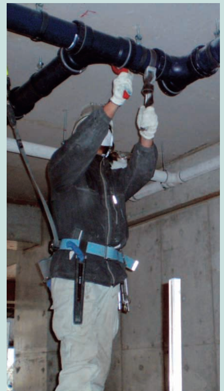
床下排水管の施工
