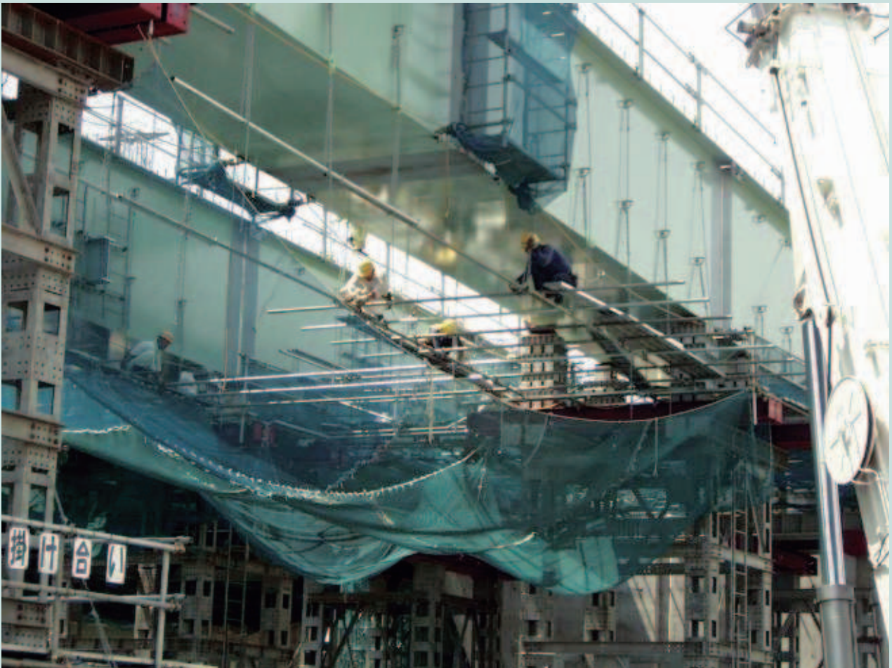
トラッククレーンベント工法の架設状況
