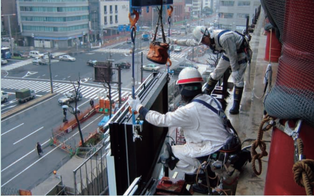
CWユニットの吊込み作業
