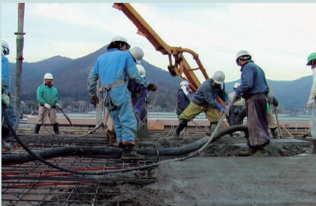
コンクリート圧送工事における筒先作業（屋根スラブ）
