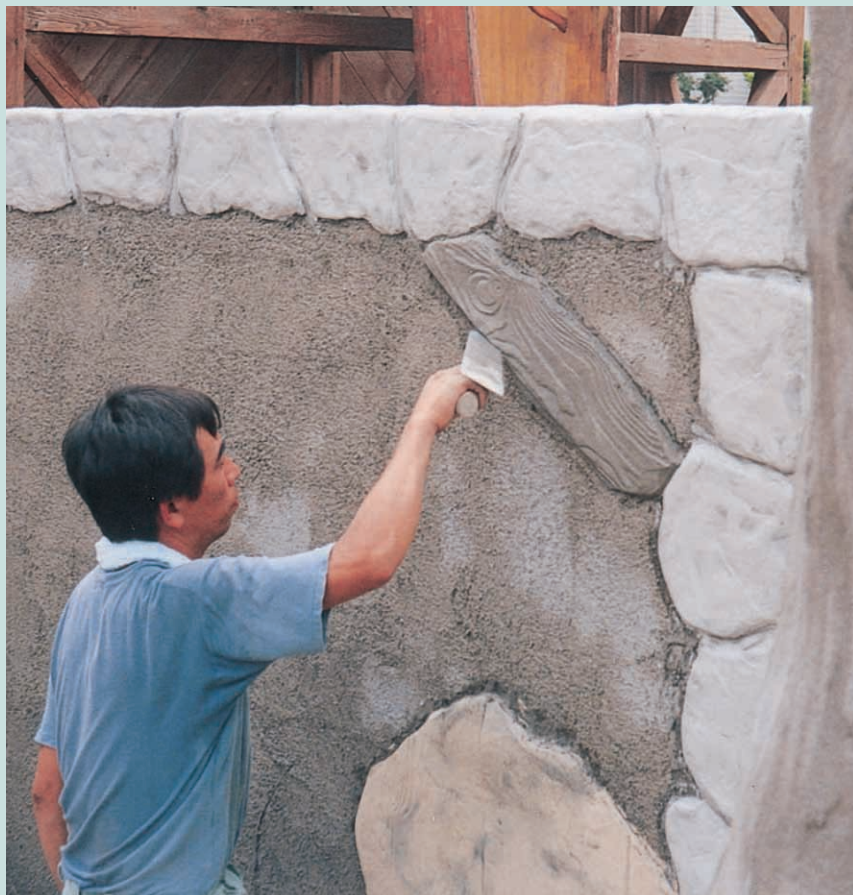
塀の化粧塗り工事施工例
