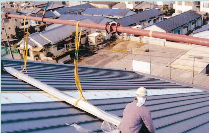
瓦棒ぶき施工現場作業（屋根材荷揚げ作業）
