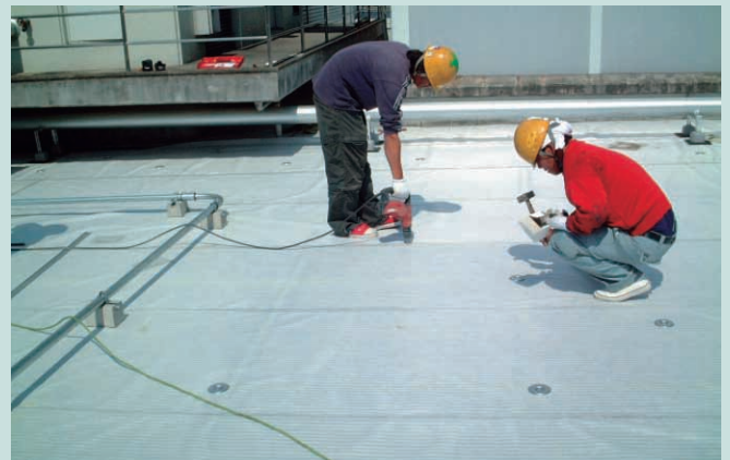
塩化ビニル系シート防水機械的固定工法
