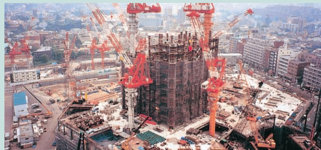
建設現場全景
