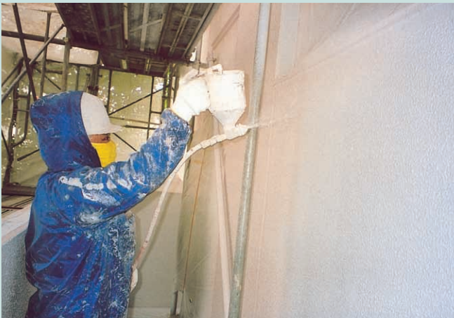
吹付け仕上げ施工
