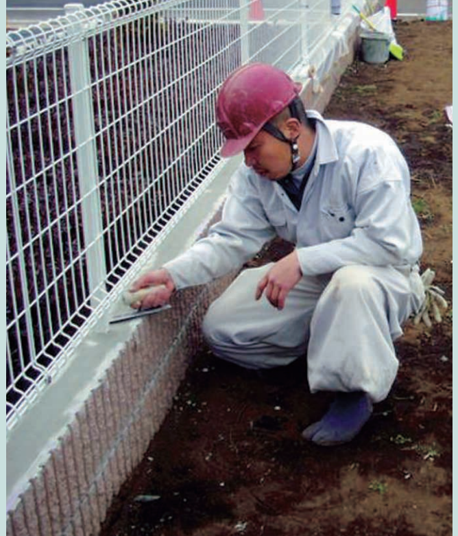
ブロック積み施工例
