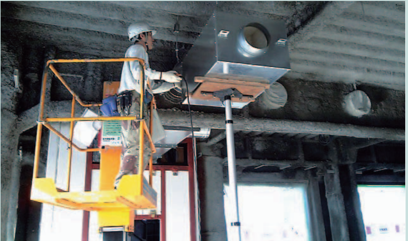
高所で空調機器類を取り付ける作業
