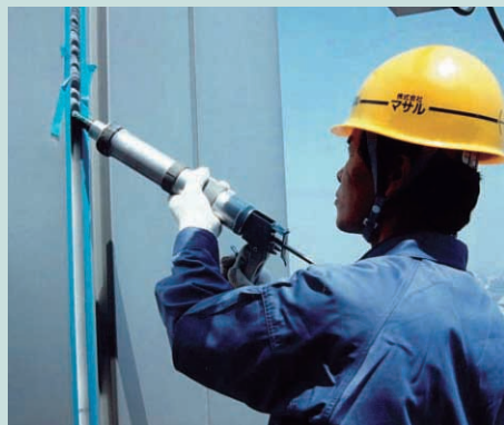
シーリング防水施工
