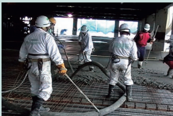
コンクリート圧送工事における筒先作業（高層スラブ床）
