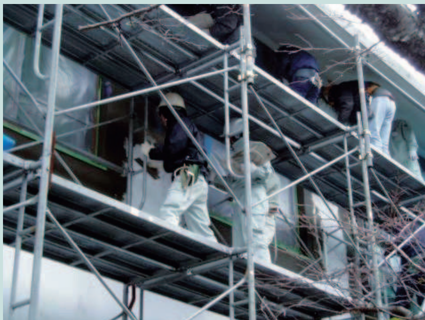
集合住宅外壁の塗替え
