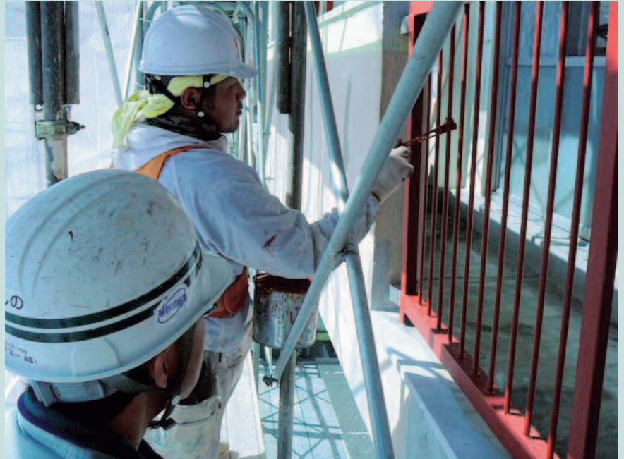
新築工事の鉄骨塗装
