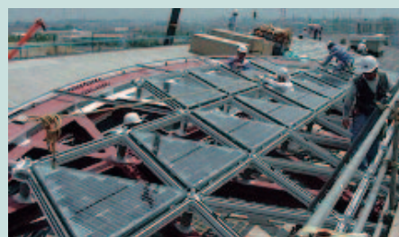
トップライト取付け工事業
