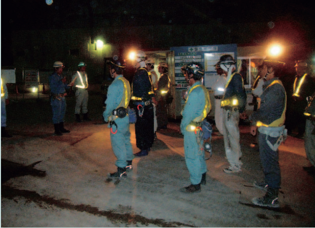
現場作業開始前のミーティング状況
