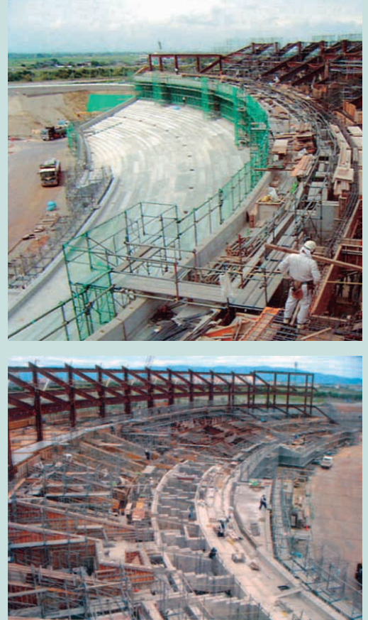
野球場のスタンド工事
