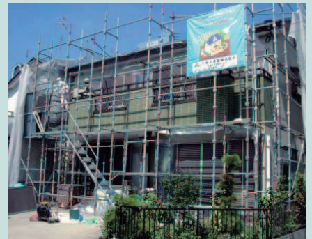
戸建て住宅の塗替え
