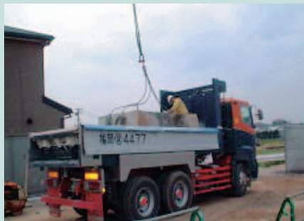
8.ブロック積み込み
