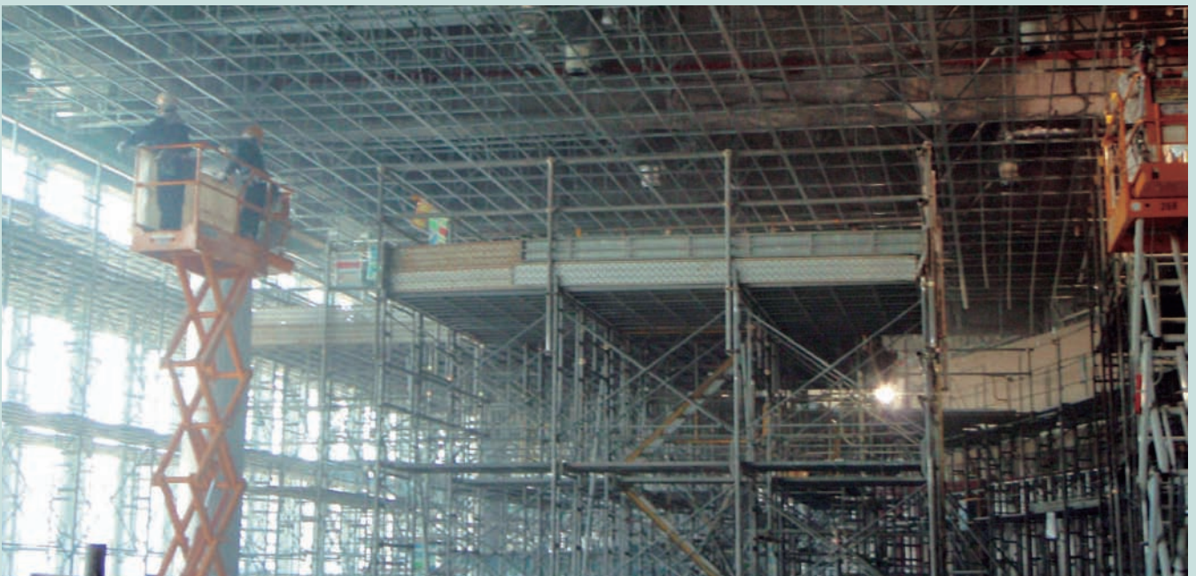
天井鋼製下地材工事作業施工
