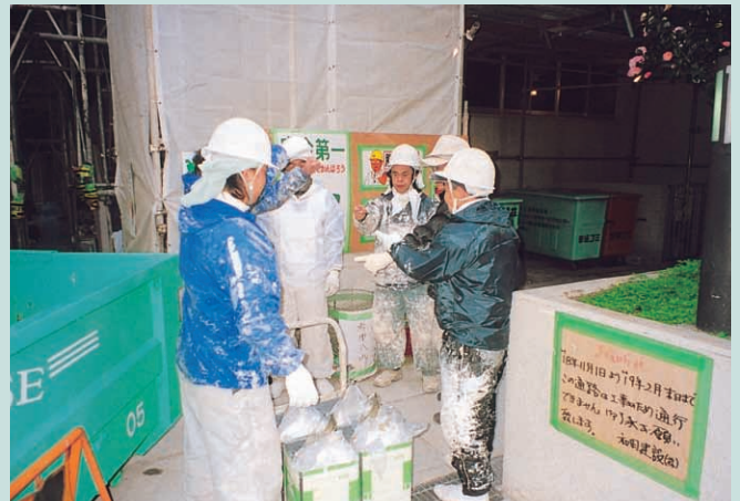
作業現場で基幹技能者が作業仕様の徹底を図る
