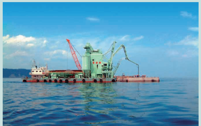
コンクリートミキサー船団の作業状況
