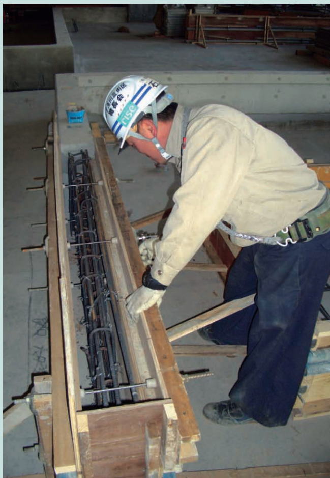
梁型枠の組立て
