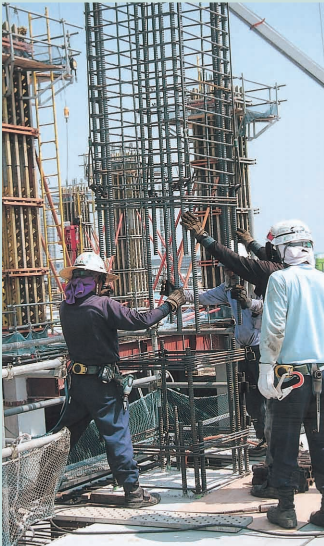
先組み柱筋の据込み
