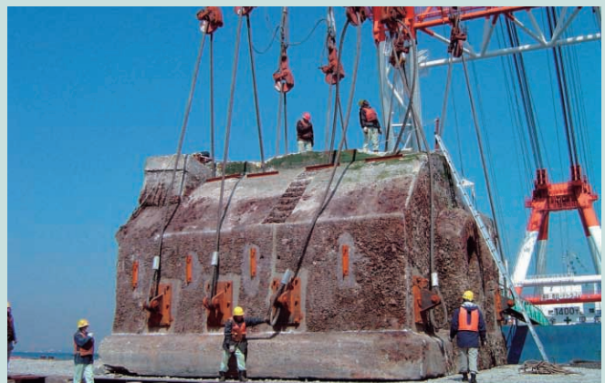
重量物吊上げ作業の指揮
