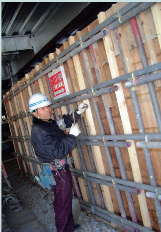
壁型枠組立て
