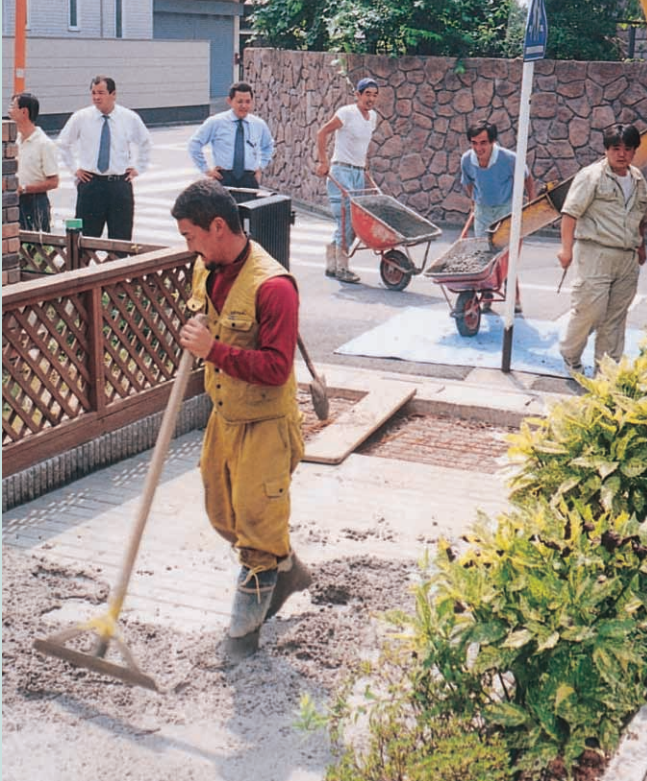
車庫廻り工事施工例
