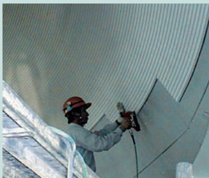
天井仕上げ工事施工
