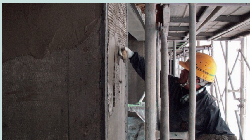
現場調合モルタルの下塗り作業
