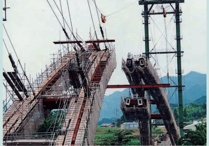
ケーブルエレクション斜吊工法の架設状況
