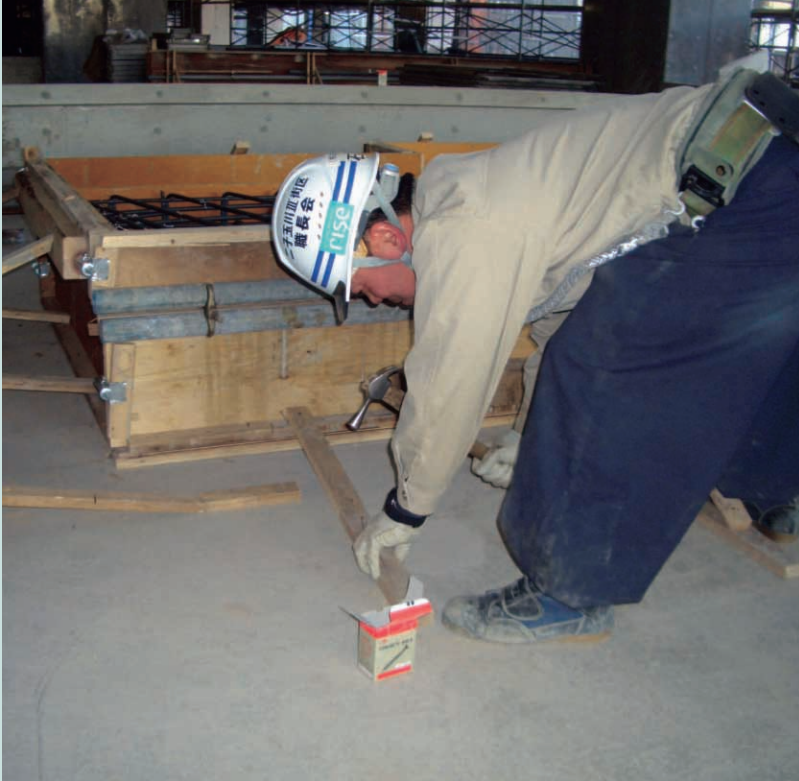
梁型枠の組立
