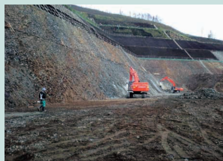
法面整形作業
