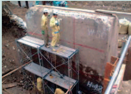
2.アンカー設置
