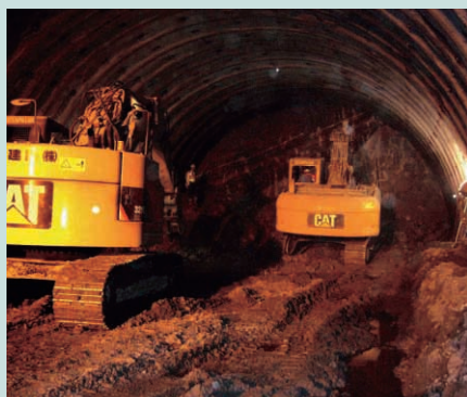
切羽機械掘削作業
