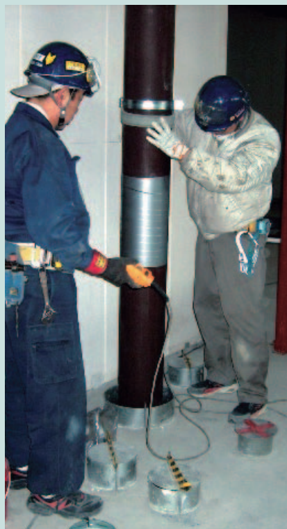
縦主管の立込み
