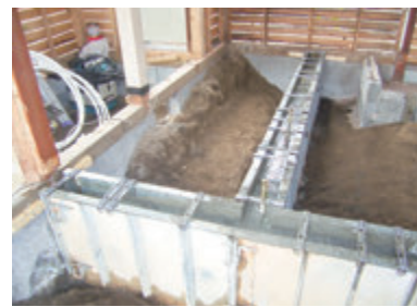
■基礎を新設する
