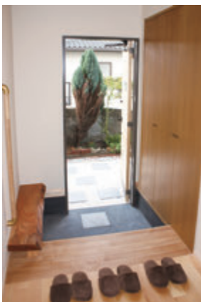
■玄関の段差軽減
