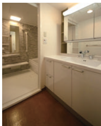
コルクタイル床の洗面室は、裸足でも安全・快適です。
