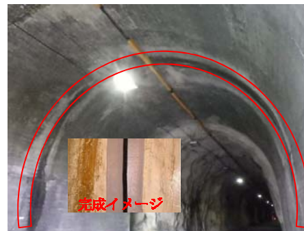
写真－9 線導水工の施工
