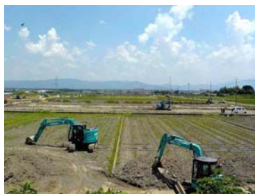
写真-1 区画拡大工事の風景
