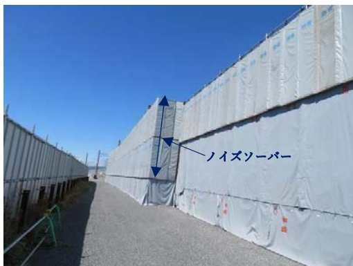
写真-4 追加対策後の防音対策状況
