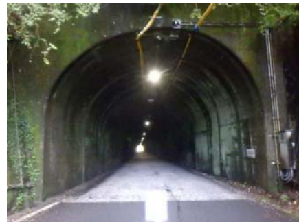
写真-1 小口第二トンネル
