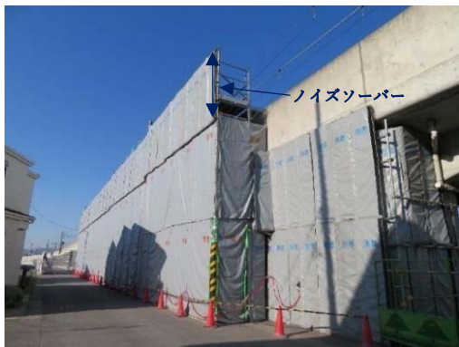
写真-3 夜間試験施工での防音対策
