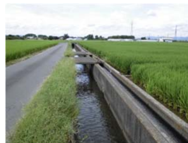
写真-3 既設の三面張水路
