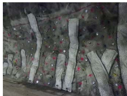
写真－7 排水マット設置
