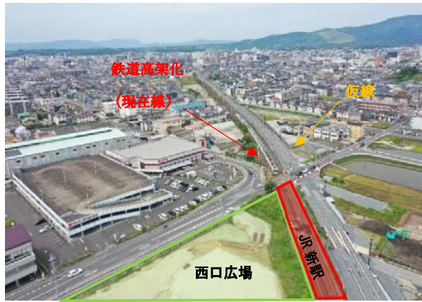
写真-1 現在の施工状況（八条踏切付近）
