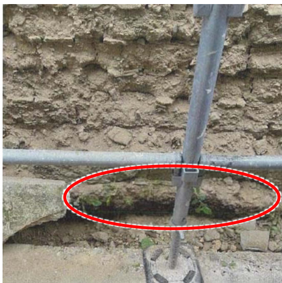
写真5. 土塀基礎石積下の土の部分
