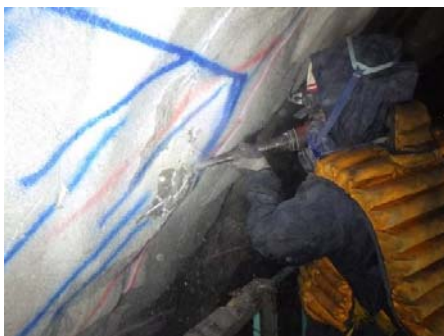
写真－6 既設モルタル吹付撤去
