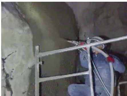
写真－8 モルタル吹付工
