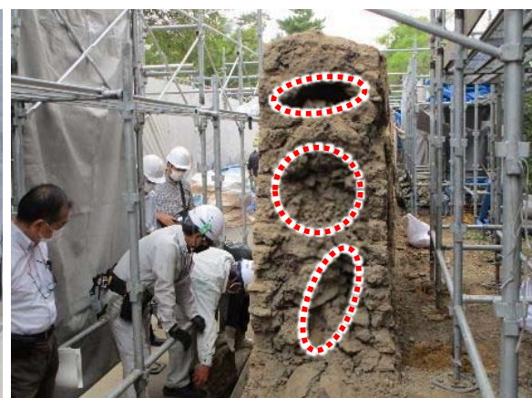
写真 4. 土塀北側断面
