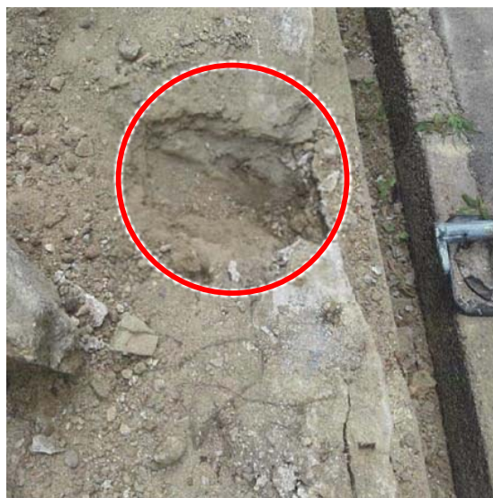
写真6. 石積みの裏込めの確認
