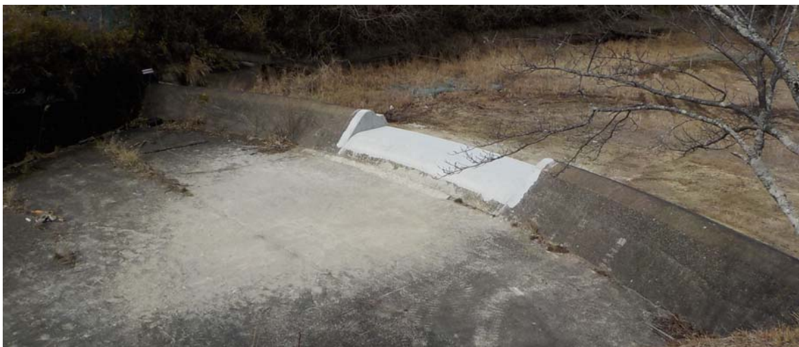
写真 2-スリット施工後の洪水吐
