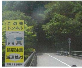
写真-11 注意喚起看板（路肩注意）
