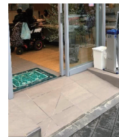
スロープの設置
