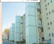
エレベータ設置
