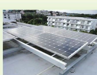
太陽光発電関連設備の設置
