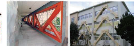
鉄骨ブレースによる壁の補強
